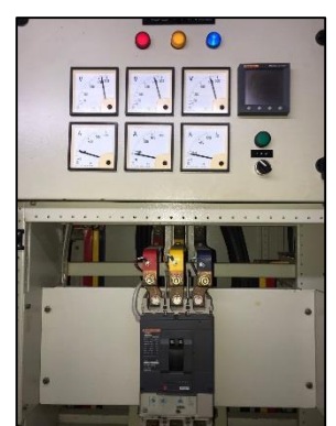
รูปที่ 3-19 การเชื่อมต่อคอนโทรลกระแสไฟฟ้าปั้มน้ำบาดาล
